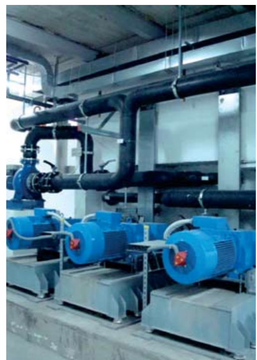
На фото: ← В гидроканале смонтированы осевые насосы с приводными двигателями
