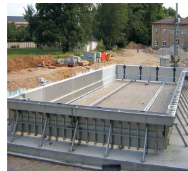
На фото: При строительстве нового бассейна стенки имеют распорки от фундаментной плиты
